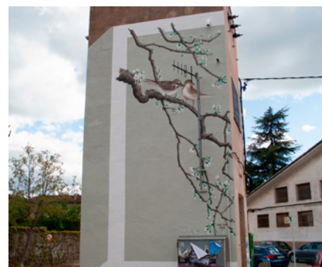
MARC REINA Torre elèctrica (c. Verge de la Mercè)
